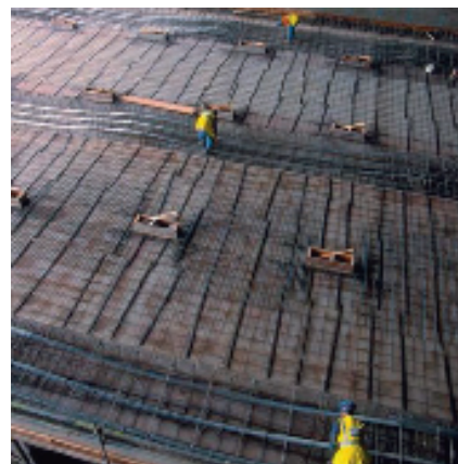
Укладка преднапряженных тросов
