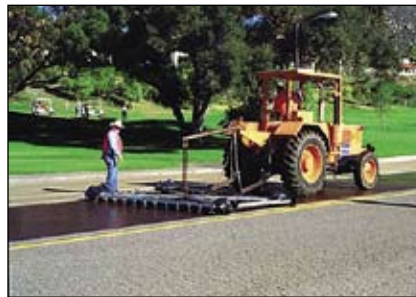
Рис. 9. Обработка покрытия Scrub Seal
