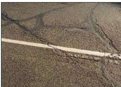
Рис. 11. Трещины, обработанные методом Crack Seal.
