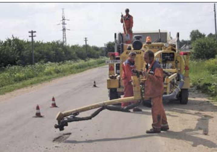
Рис. 2. Выполнение работ по устранению ямочности
