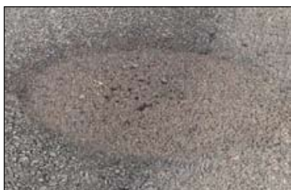
Рис. 3. Запломбированная выбоина
