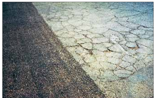
«Кейп Сил» с резинобитумной мембраной
