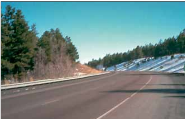
Уложенная горячая смесь на основе резинобитума на горе Доннера.
