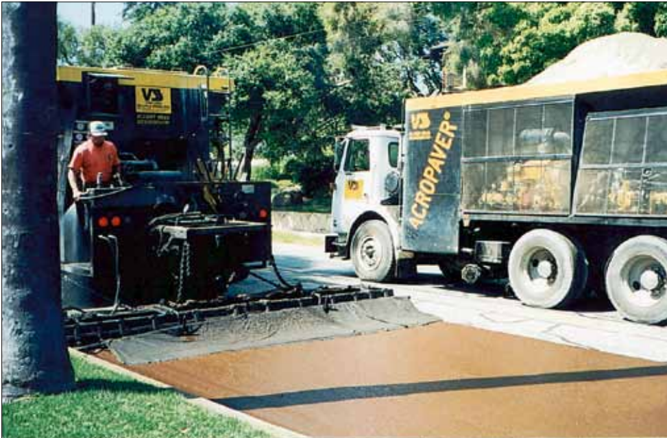
Укладка Микросюрфейсинга.
