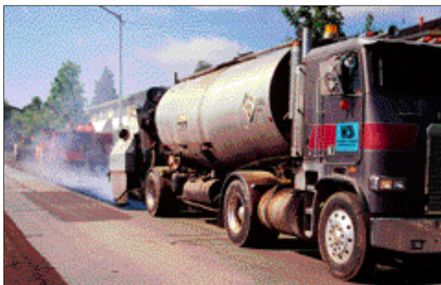
Устройство поверхностной обработки с применением резинобитумного вяжущего.
